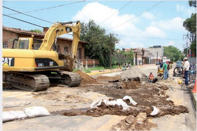
Una de las acciones más relevantes que forma parte de los esfuerzos de los tres niveles de gobierno, se realizó durante los meses de agosto a diciembre de 2018 con la firma de los convenios de servidumbre de paso y se instalaron 712 metros de tubería de 24 pulgadas de diámetro que forman parte del tramo uno de la última etapa del Colector Norte.
